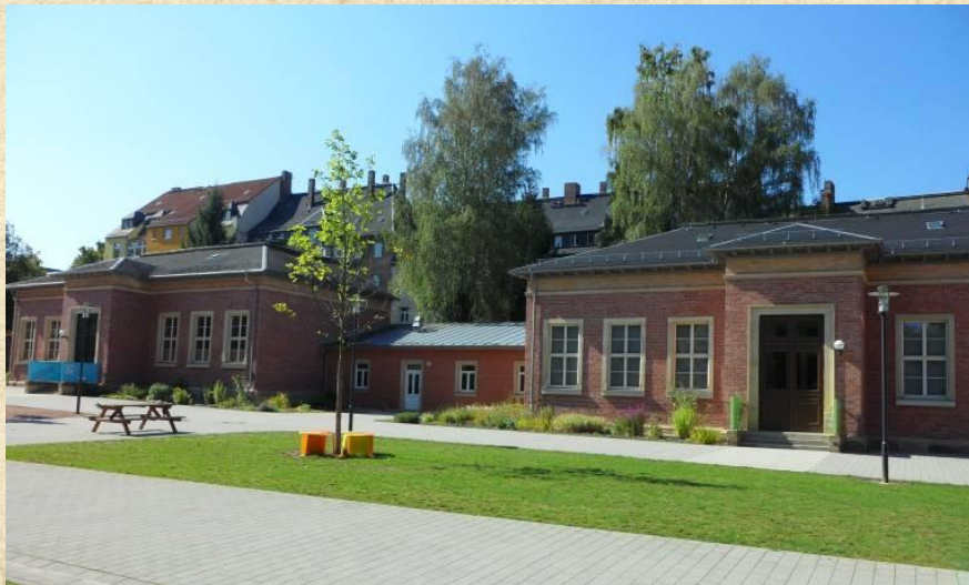
Nebengebäude (Kunstraum, Werkenraum, Turnhalle)
